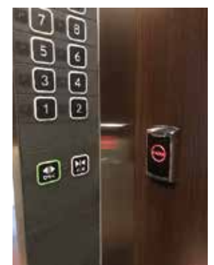
エレベータ籠内施工例
